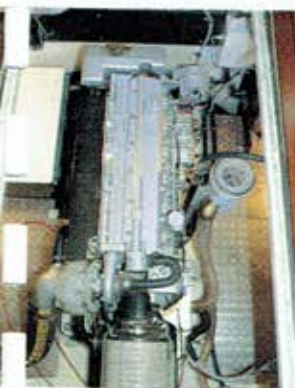
De Vetus Deutz in de goed geïsoleerde ruimte van de Goodvaer.
